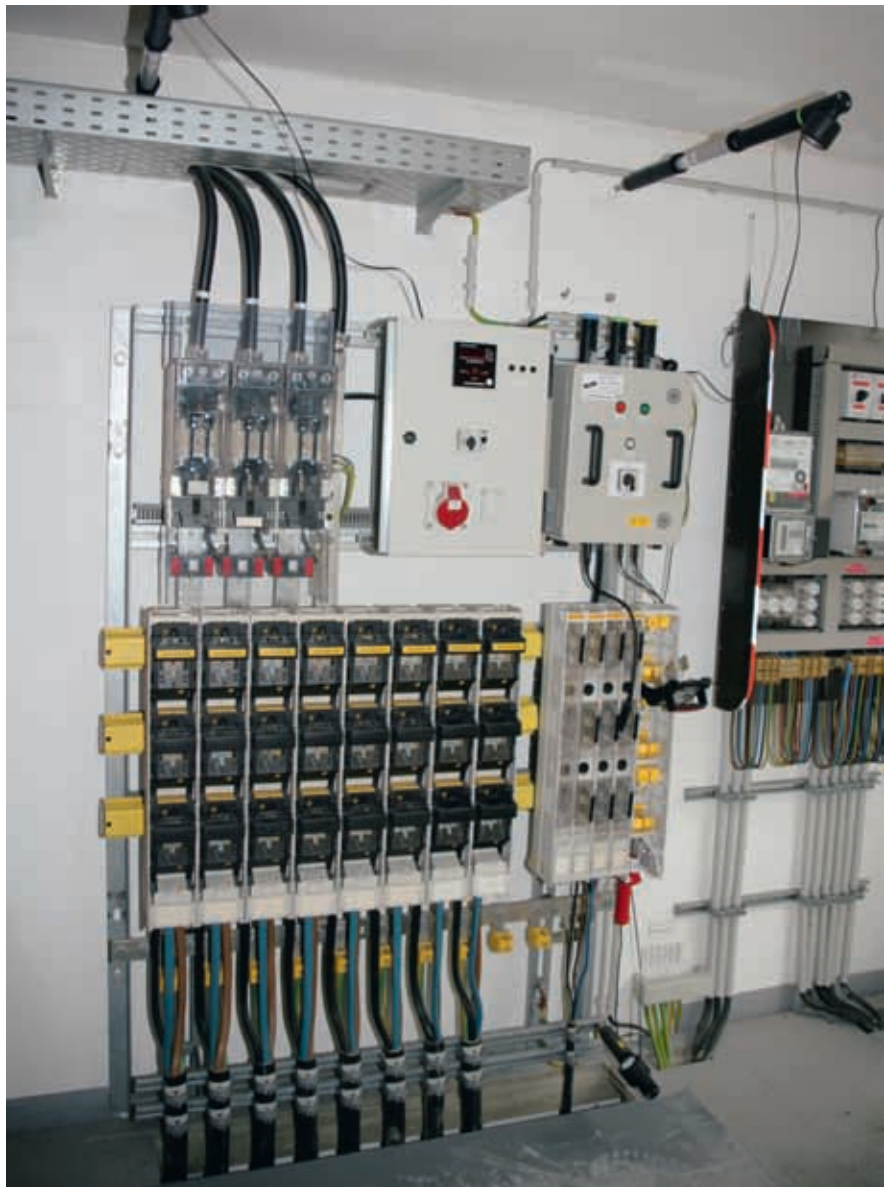
Bild 6: Lichtbogenenschutz-System fertig montiert (vor Einsetzen der Kurzschlusspatronen/ Trennmesser)
