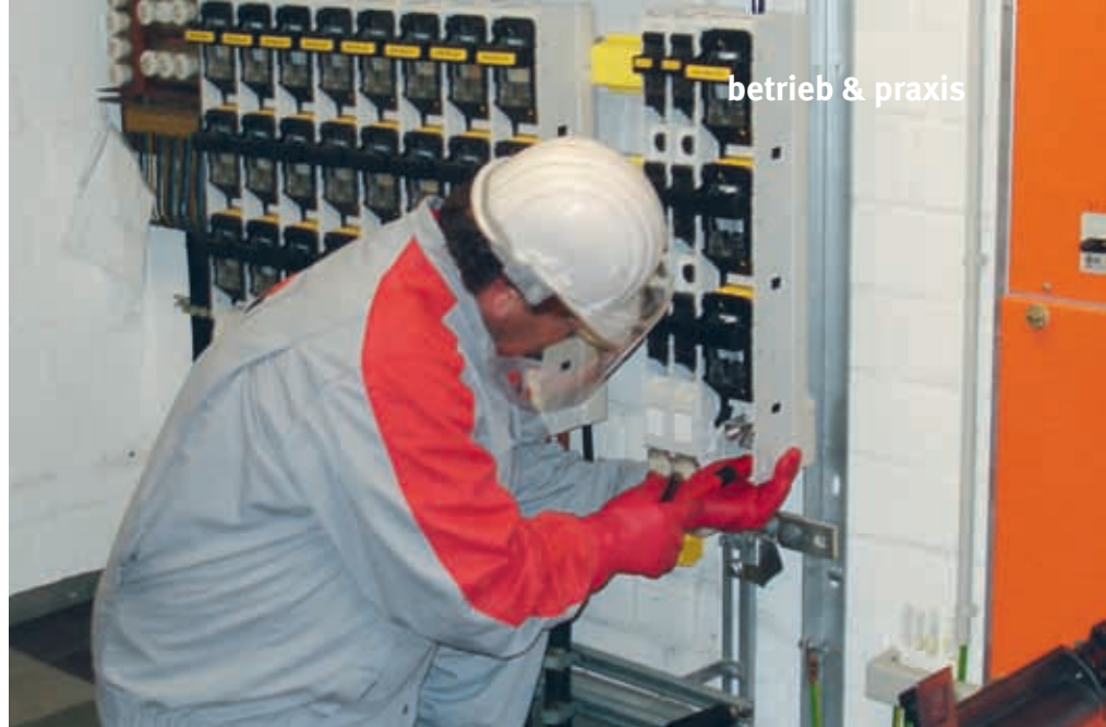
Bild 2: Einbau einer verriegelbaren NH-Sicherungsschaltleiste
