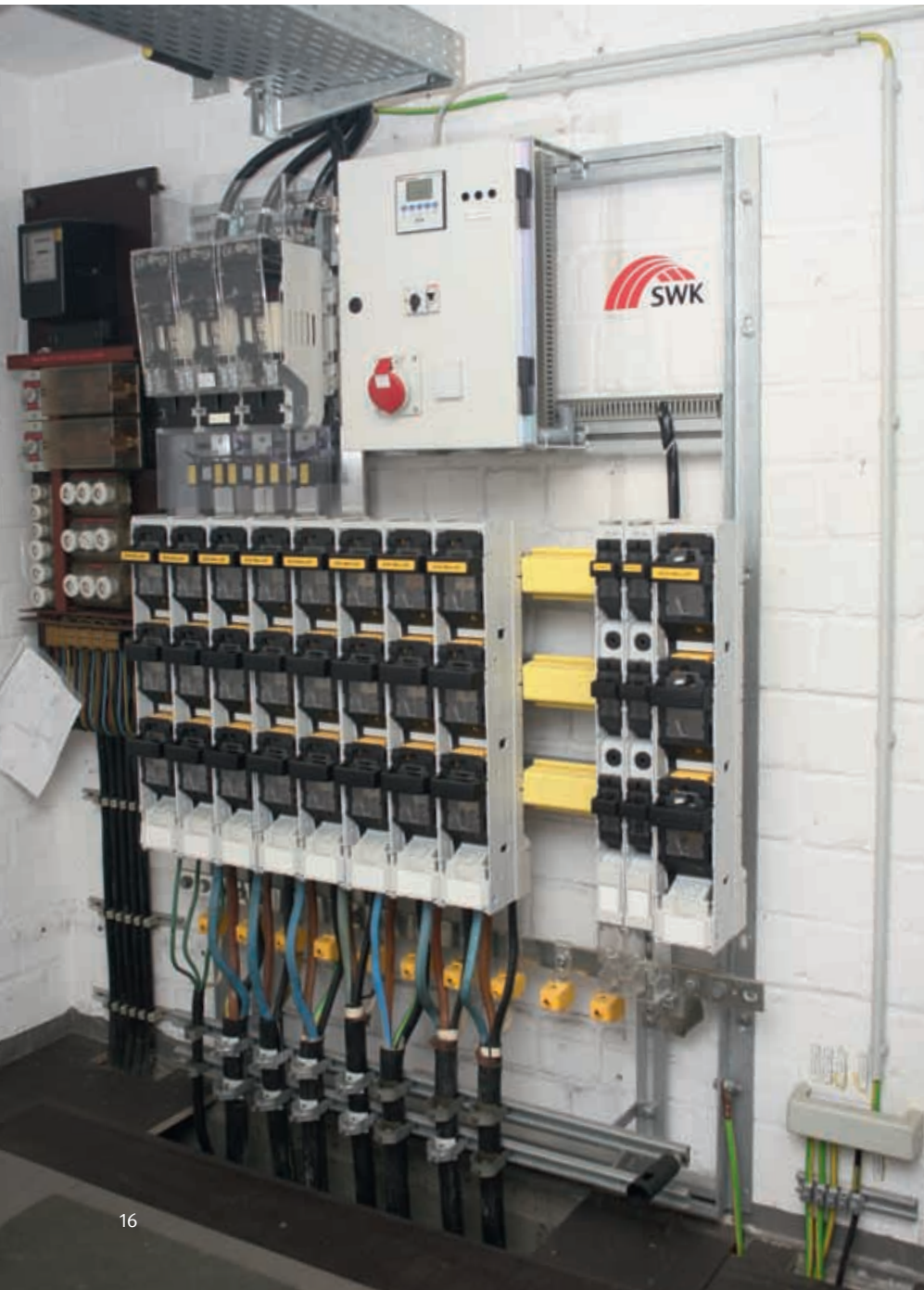
Bild 1: Sammelschienenverbindung mit Abdeckung
